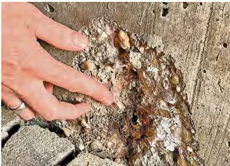
Der Beton, Baujahr 1984, muss auf Tausenden Quadratmetern untersucht und vielerorts ausgebessert werden.
